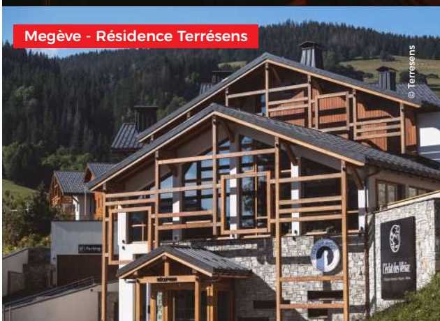
Megève - Résidence Terrésens
